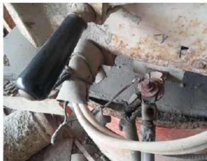
通路上使用電線，應避免損傷絕緣
