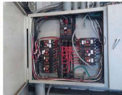
電氣機具帶電裸露處應設護圍或絕緣被覆(中隔板、電器開關箱等)
