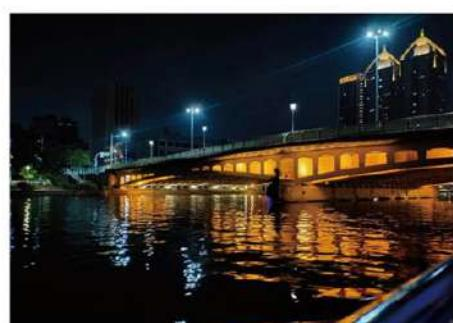
**【中正橋】**昔稱大橋，是來往鹽埕區與前金區的主要橋梁，為愛河上最寬的橋，建於 1931 年，初以木頭搭建，1938 年為配合中正路的闢建而改建成擁有五個橋孔的水泥橋；1992 年再度改建成長 92 公尺，寬 40 公尺的二跨鋼構橋，橋下設有人行步道，其雙跨的鋼構號稱是愛河上最美的橋，橋下的鋼拱結構，猶如一道彩虹，甚具美感。
